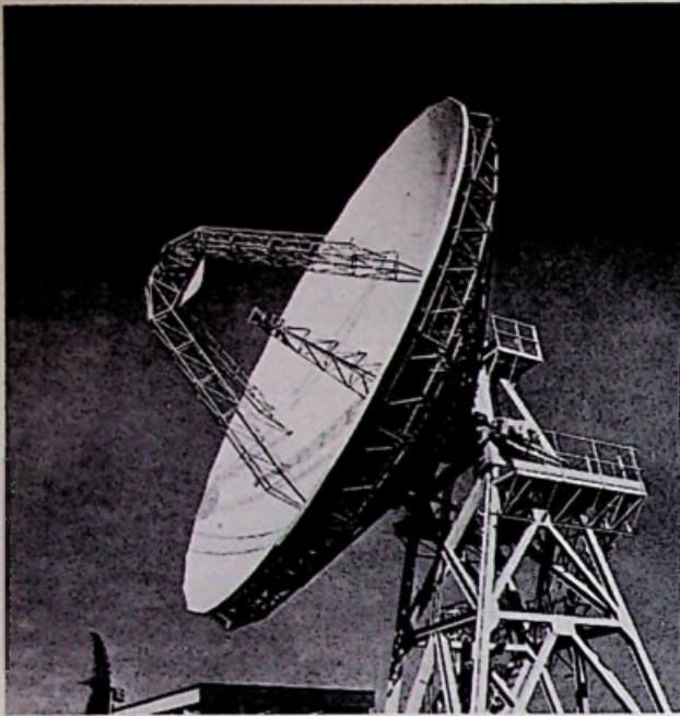
Afb. 5. 14 m-parabool van een experimenteel grondstation op het eiland Wight, gebouwd door Plessey.
